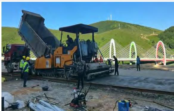
首次透水水泥路面机械化摊铺施工
