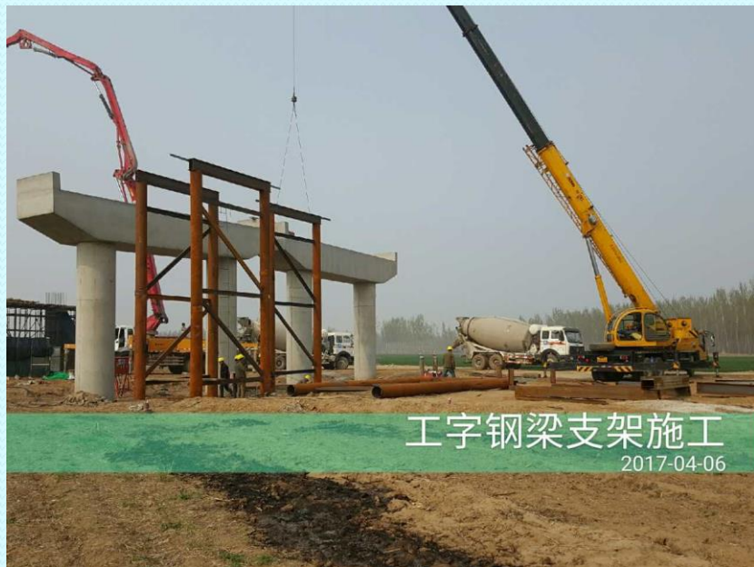
工字钢梁支架施工
