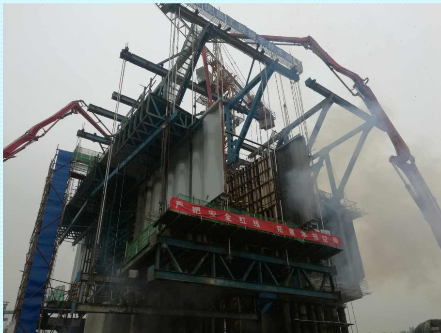
南水北调特大桥18#墩右幅2#块底腹板砼浇筑
