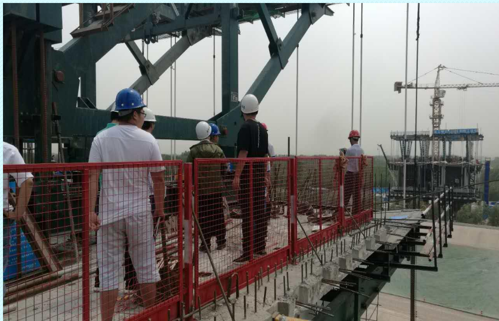
南水北调特大桥挂篮施工现场
