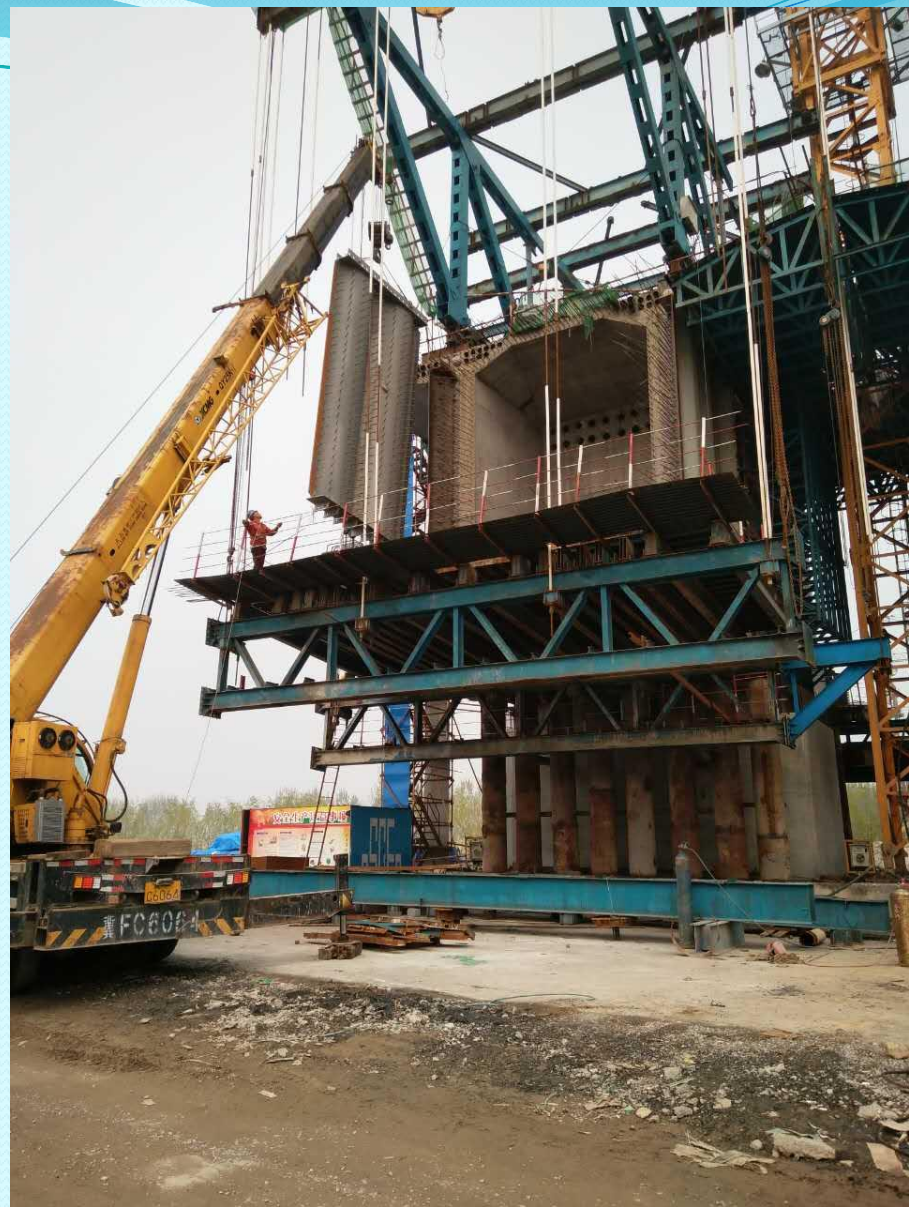
南水北调特大桥18#墩右幅2#块波形刚腹板吊装
