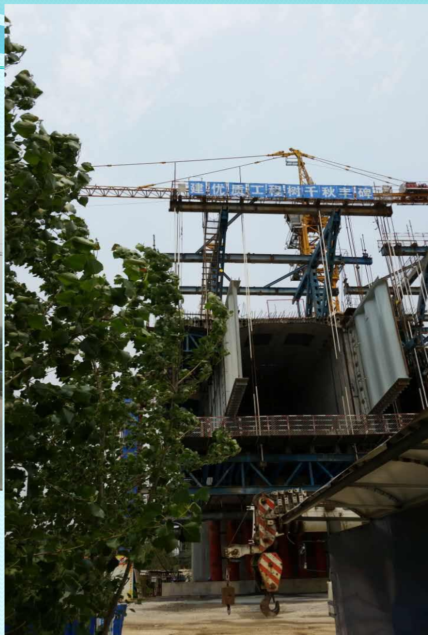
南水北调特大桥挂篮施工现场
