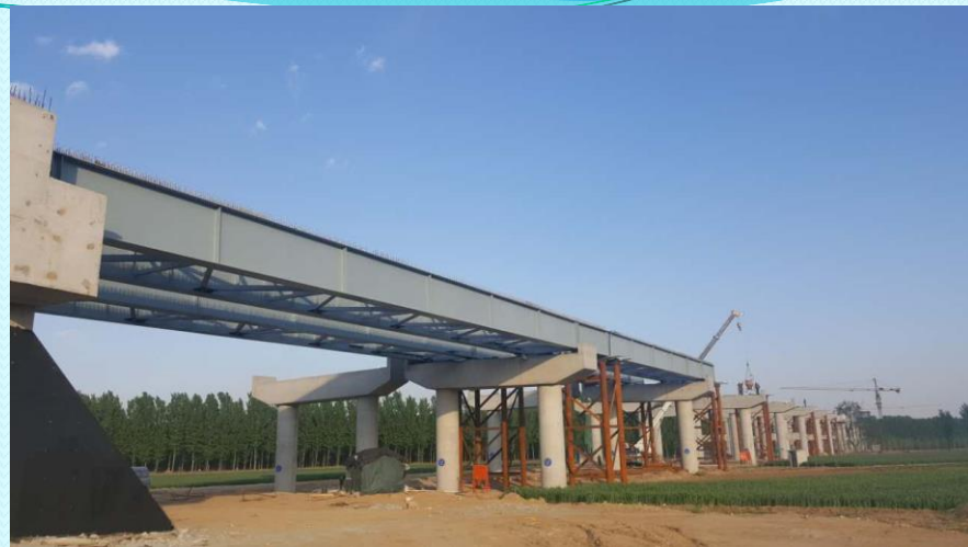
南水北调特大桥引桥工字钢梁第二跨架设完成
