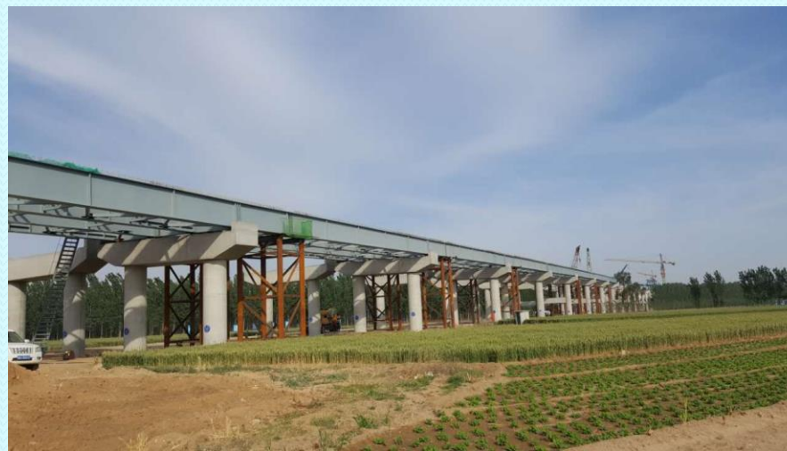
南水北调特大桥引桥工字钢梁第二跨架设完成
