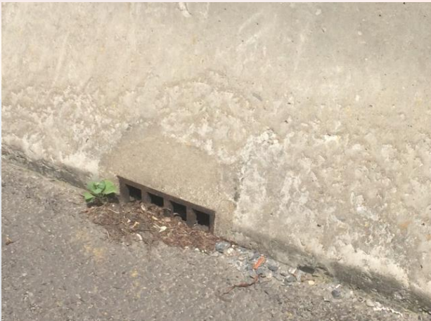
横向泄水孔 transverse inlet
