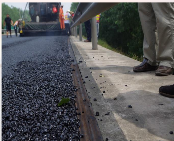
纵向导水槽 longitudinal gutter
