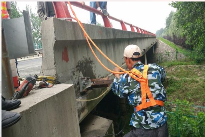
伸缩缝位置打孔 boring
