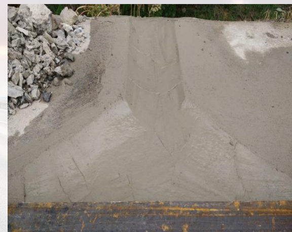
横向泄水口 transverse discharge
