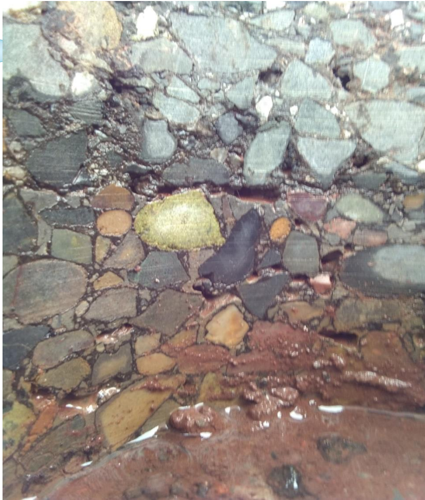
钻芯孔内情况 (降雨3d后)
