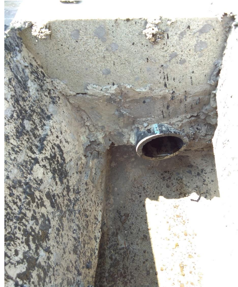
雨水井内软式盲管 (降雨3d后)
