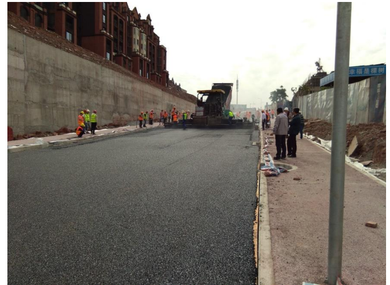
基体沥青混合料施工
