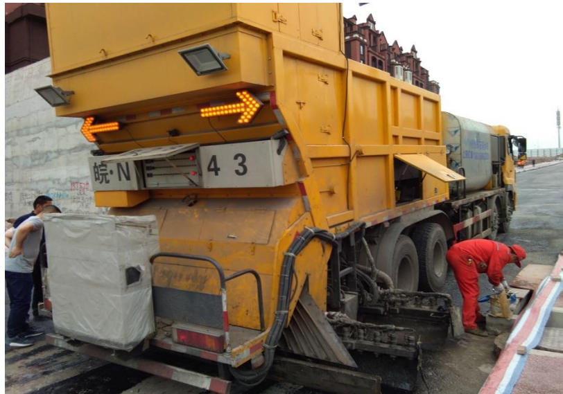
橡胶沥青纤维增强碎石封层施工
